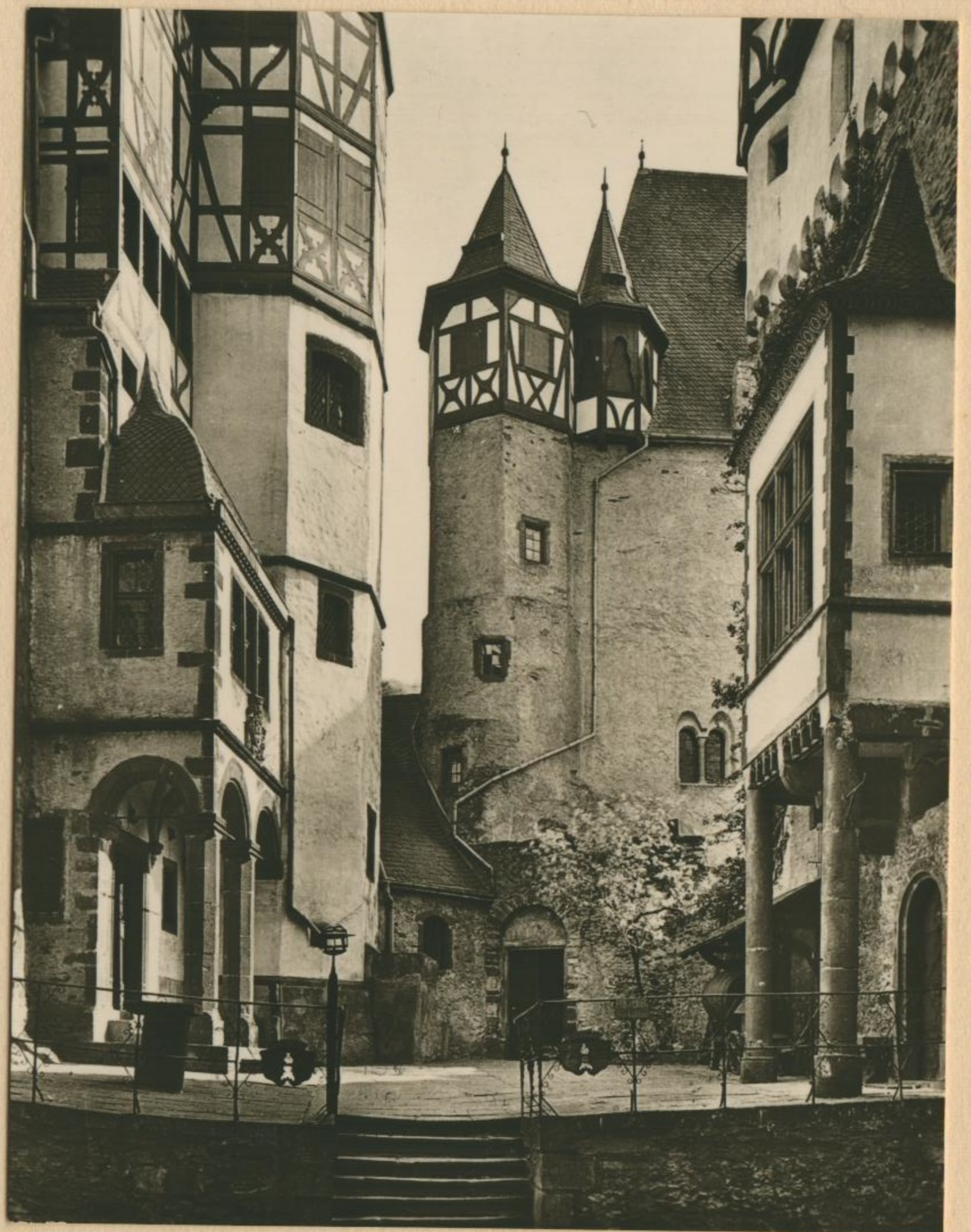
Platz Eltz (hinten) Rübenacher Haus (rechts) Kempenicher Haus (links)
