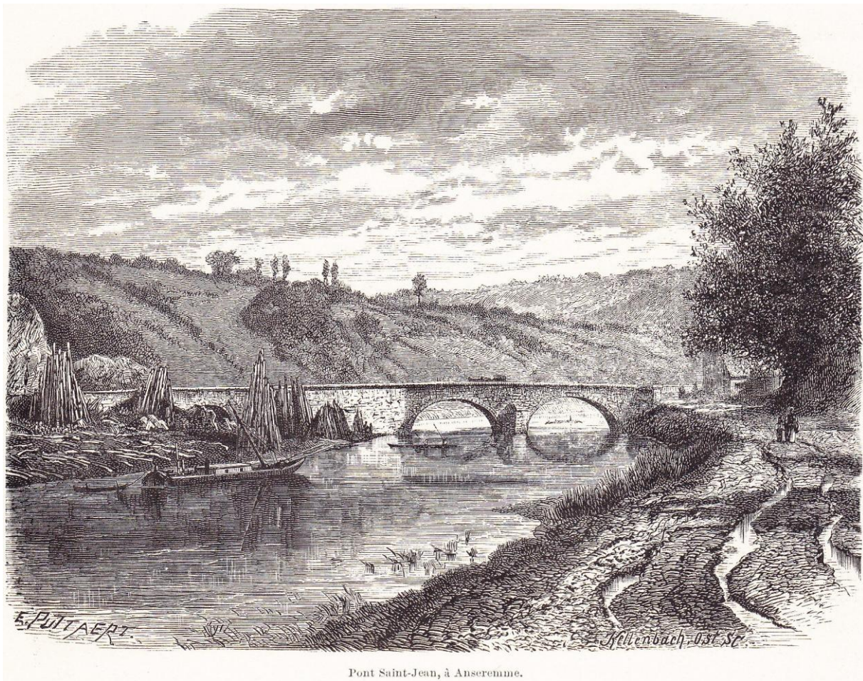
Pont Saint-Jean, à Anseremme.
