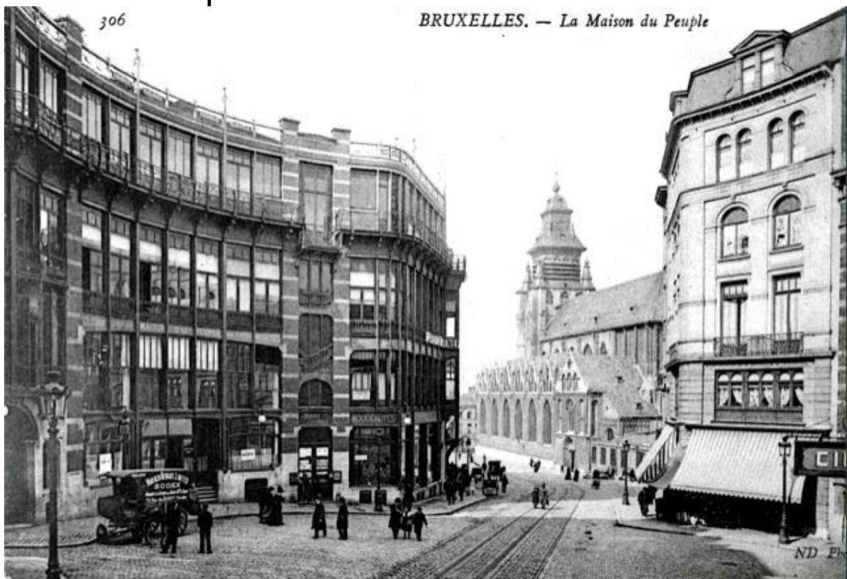
Bruxelles - La Maison du Peuple, place Joseph Stevens Conçue par Victor Horta pour le Parti Ouvrier Belge Inaugurée en 1899 en présence de Jean Jaurès Détruite en 1965
